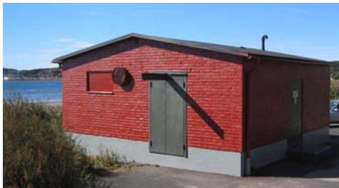
Pumpstation, Va-Verket i Göteborg
